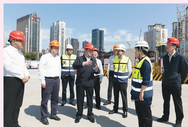
5月17日,上海市委副书记、市长龚正带队来到集团承建的华兴新城项目,现场察看工地建设情况,检查工地环境,详细了解噪声、扬尘、渣土、光污染等环保防治措施。建工集团党委书记、董事长杭迎伟,党委副书记、总裁叶卫东,建工集团副总经济师、一建集团党委书记、董事长徐懿等随队陪同。(记者 乔恒昌 报道)
