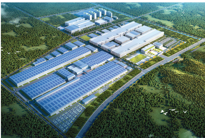
日前,四川公司中标中创新航成都项目二期施工总承包二标段工程。项目总建筑面积14.7万平方米,中标金额约9.39亿元,合同工期为365日历天,包含电芯车间、电板车间、成品库及配套用房等。项目建成后承担二期30GWh动力及储能电池核心产能的建设任务,并与一期产能整合,成为中创新航在西南地区的战略支点,强化四川在锂电产业链的核心地位。(通讯员 王澜 报道)
