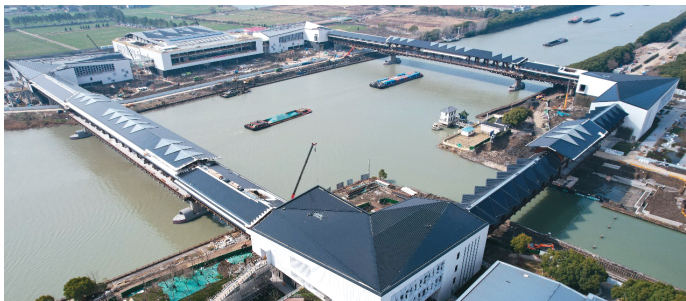
近期,电建工程公司承建的“一点”方厅水院项目传来最新消息,施工单位顺利完成浇筑后,三层步廊桥进入装修收尾阶段,主会馆、浙江馆及安徽馆已完成幕墙施工,正全面开展室内精装修和室外景观施工,项目预计于今年5月底竣工。
